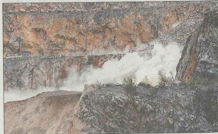
Der Abbau im Steinbruch geht stetig voran - die Staubbelastung sei dementsprechend hoch, so die Bürgerinitiative. Foto: Rittler
